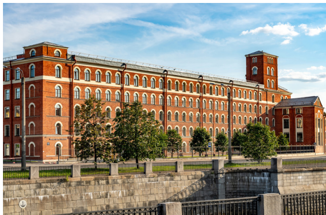
Наб. Обводного канала, д. 60
